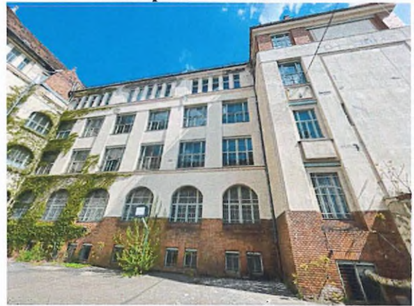
1. sz. épület homlokzatai – lépcsőépület
