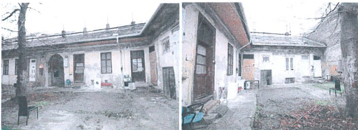
Lakóház udvari homlokzata
