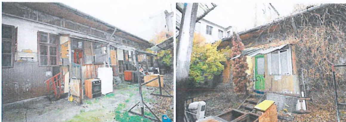
Lakóház udvari homlokzata
