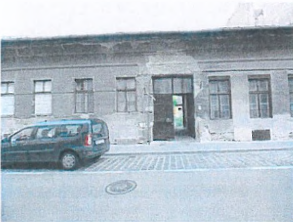
A lakóház utcai homlokzata
