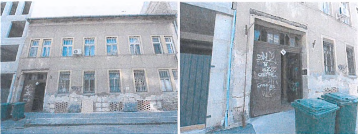
A lakóház utcai homlokzata
