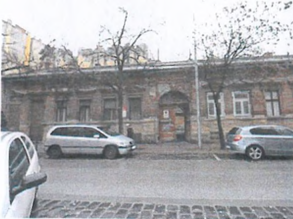
A lakóház utcai homlokzata
