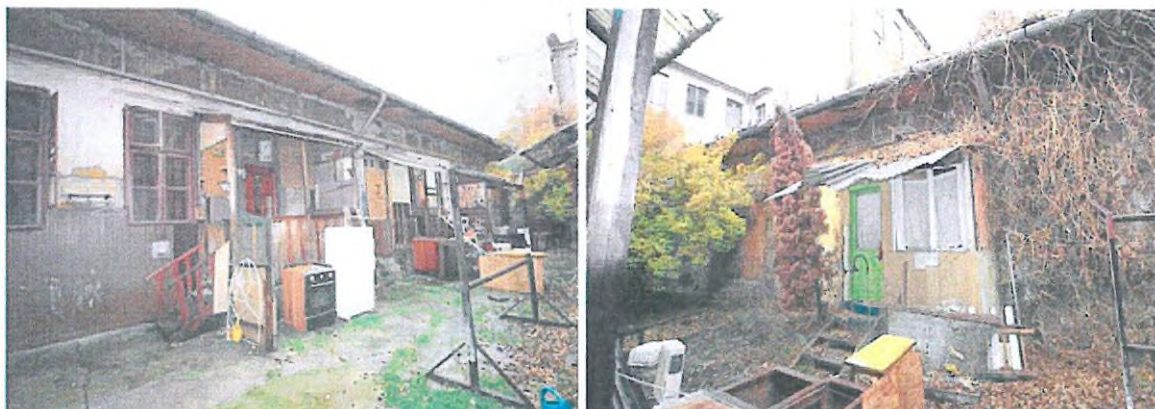
Lakóház udvari homlokzata
