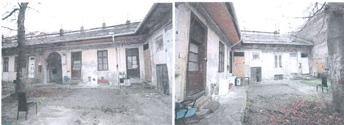
Lakóház udvari homlokzata
