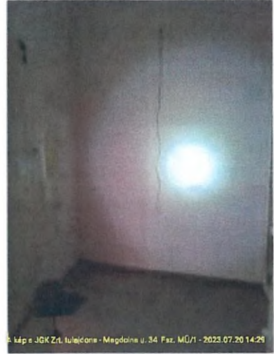
A kép a JGK Zrt. tulajdona - Magdolna u. 34. Faz. MŰ/1 - 2023.07.20 14:29
