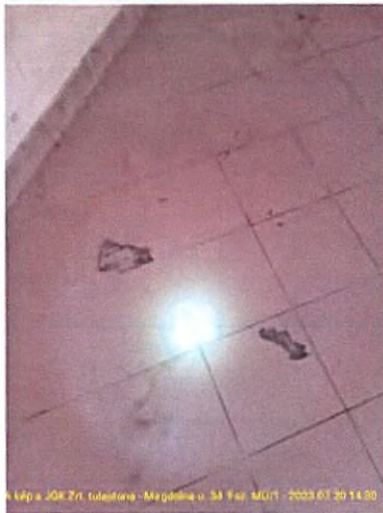
A kép a JGK Zrt. tulajdona - Magdolna u. 34. Faz. MŰ/1 - 2023.07.20 14:30
