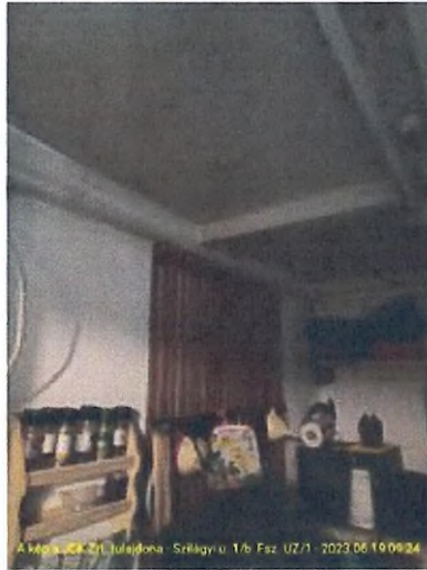
A kép a JGK Zrt. tulajdona - Szilágyi u. 1/b. Faz. UZ/1 - 2023.06.19.09.24
