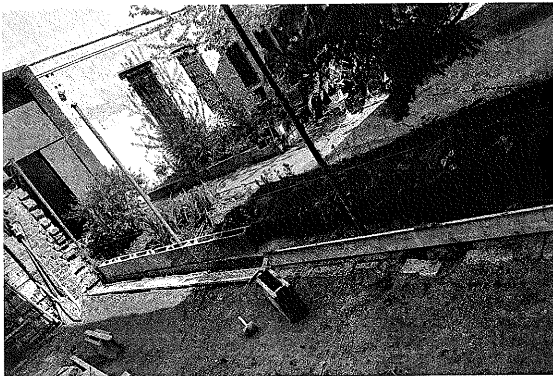
2. számú fotó- kerítés építés közben
