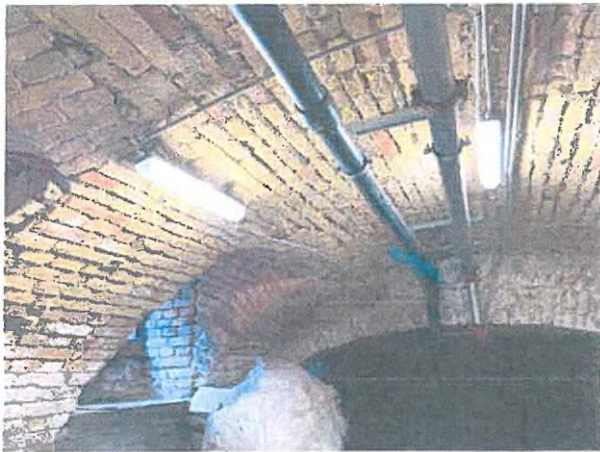
09. víz-, és tűzvíz hálózat bejövő csővezetéke
