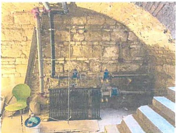
08. víz-, és tűzvíz hálózat bejövő csővezetéke
