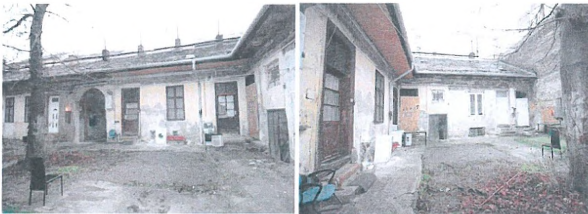
Lakóház udvari homlokzata
