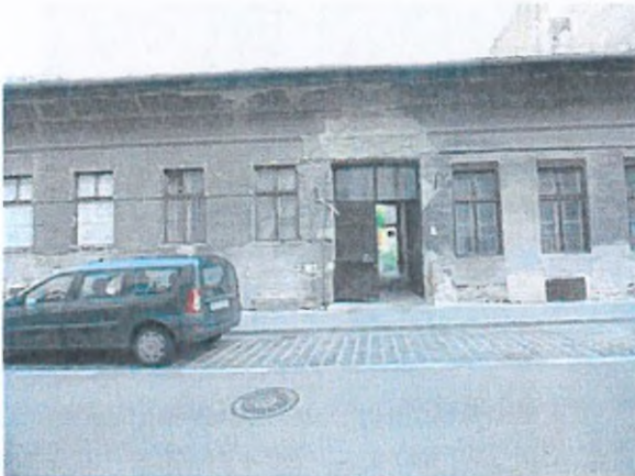
A lakóház utcai homlokzata
