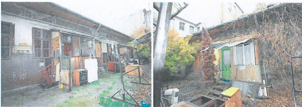
Lakóház udvari homlokzata
