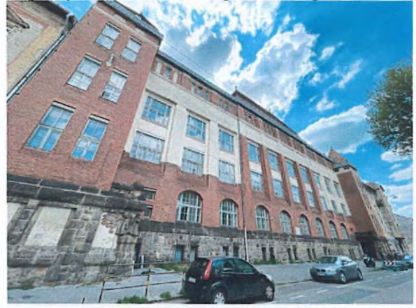
1. sz. épület homlokzatai
