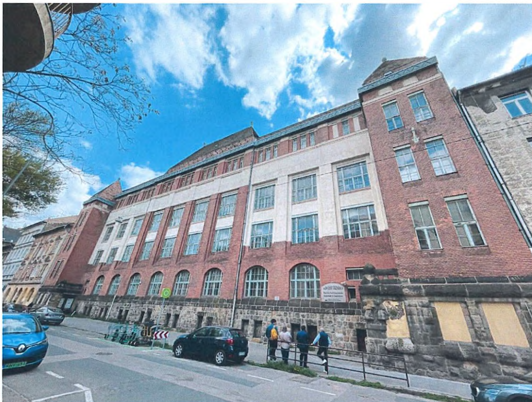
Dugonics utcai homlokzat
