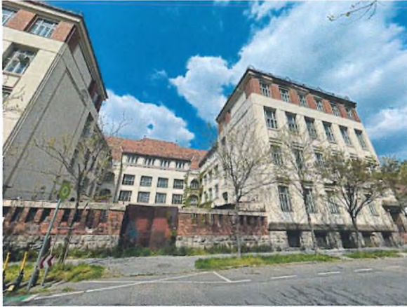
1. sz. épület homlokzatai
