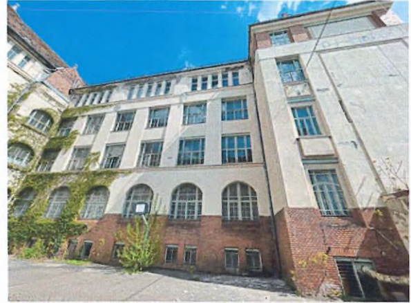
1. sz. épület homlokzatai – lépenyépület
