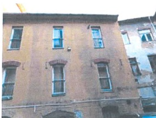
06. az értékelt épületrész homlokzata az udvarról
