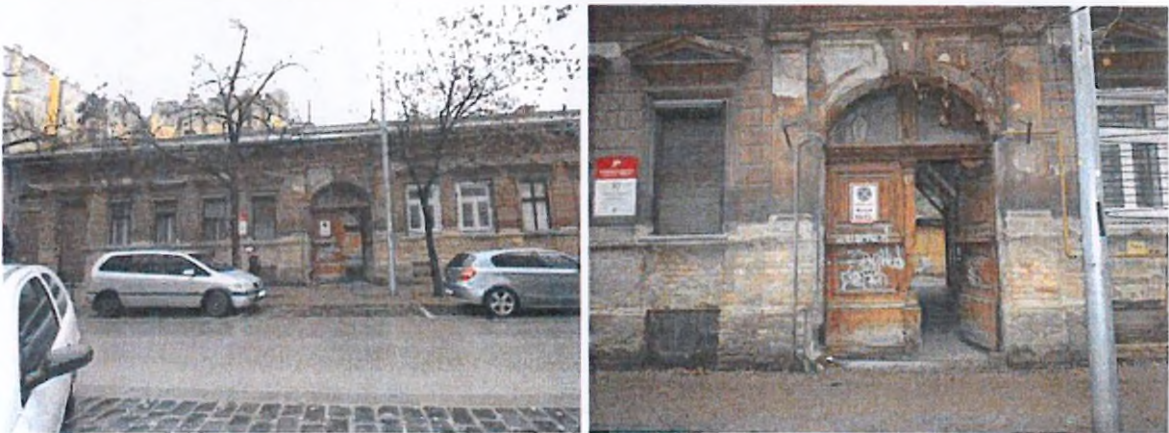
A lakóház utcai homlokzata
