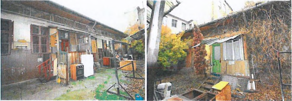
Lakóház udvari homlokzata
