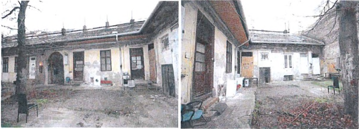
Lakóház udvari homlokzata
