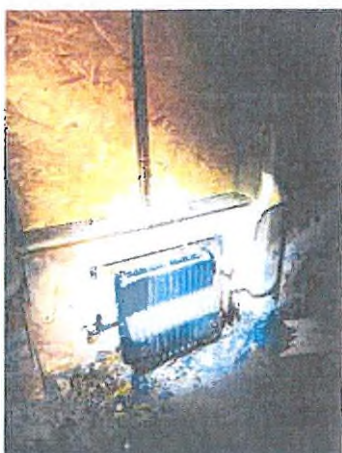
20. burkolat nélküli gázkonvektor
