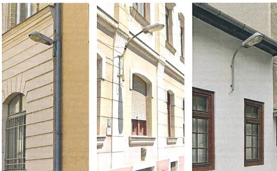
Fali karos Siteco típusú lámpatestek a Nap utca külső szakaszán
