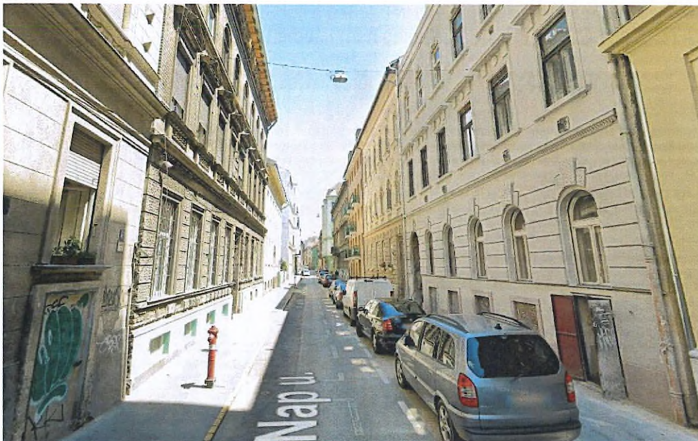
Átfeszítéses Schröder Medio típusú lámpatest a Nap utca belső szakaszán
