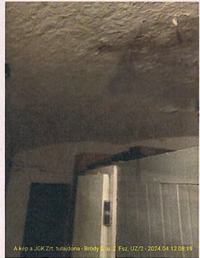
A kép a JGK Zrt. tulajdona - Bródy S. u. 2. Fsz. UZ/2 - 2024.04.12.08:19
