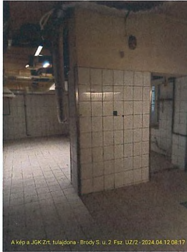
A kép a JGK Zrt. tulajdona - Bródy S. u. 2. Fsz. UZ/2 - 2024.04.12.08:17
