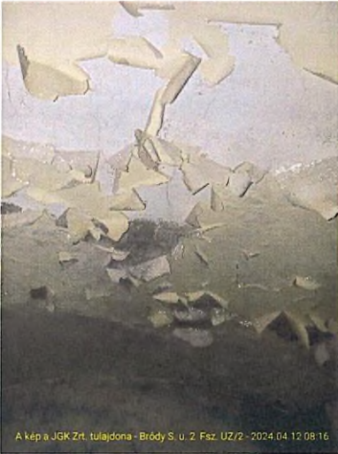
A kép a JGK Zrt. tulajdona - Bródy S. u. 2. Fsz. UZ/2 - 2024.04.12.08:16
