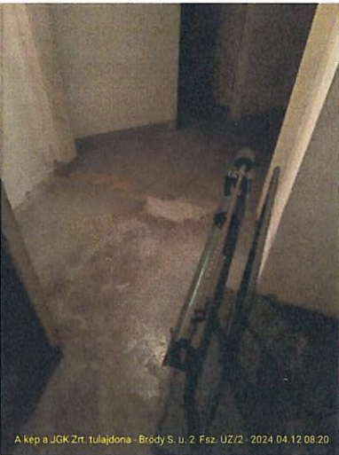
A kép a JGK Zrt. tulajdona - Bródy S. u. 2. Fsz. UZ/2 - 2024.04.12.08:20
