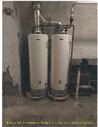
A kép a JGK Zrt. tulajdona - Bródy S. u. 2. Fsz. UZ/2 - 2024.04.12.08:21
