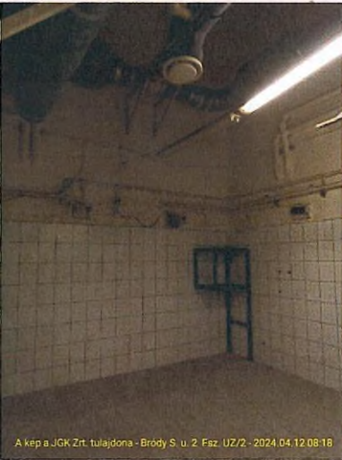
A kép a JGK Zrt. tulajdona - Bródy S. u. 2. Fsz. UZ/2 - 2024.04.12.08:18
