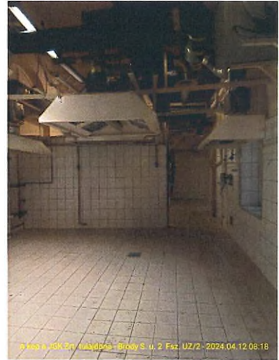
A kép a JGK Zrt. tulajdona - Bródy S. u. 2. Fsz. UZ/2 - 2024.04.12.08:18
