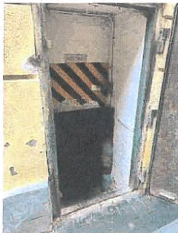
06. ingatlan megközelítése Bacsó Béla utca felől
