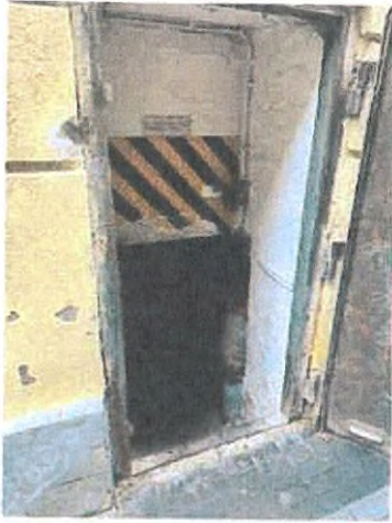
06. ingatlan megközelítése Bacsó Béla utca felől
