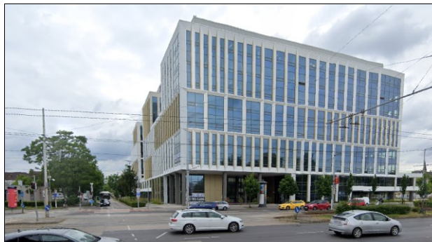
Az Arena Business Campus béirodaház a Hungária körút felől
