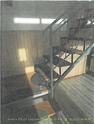
A kép a JGK Zrt. tulajdona - Teleki tér 23. Fsz. UZ - 2024.01.04 09:39
