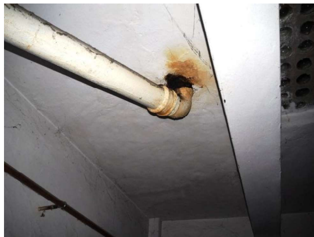
25. rozsdás csőrendszer
