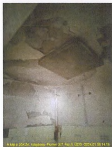
A kép a JOK Zrt. tulajdona - Fiumei út 7. Fsz./1. ÚZ/3 - 2024.01.08 14:16
