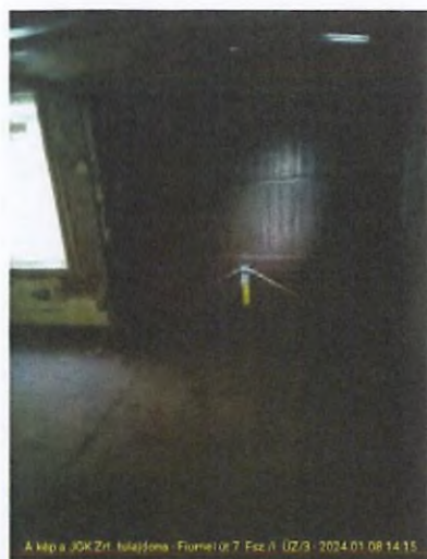
A kép a JOK Zrt. tulajdona - Fiumei út 7. Fsz./1. ÚZ/3 - 2024.01.08 14:15
