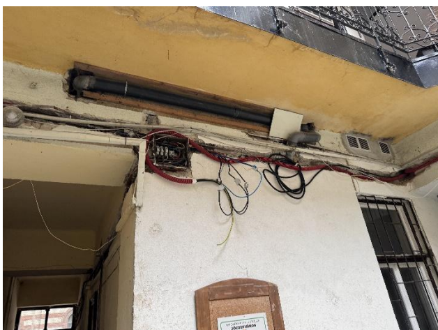
08. felújítás alatt álló elektromos hálózat
