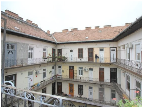
Társasház udvari homlokzata
