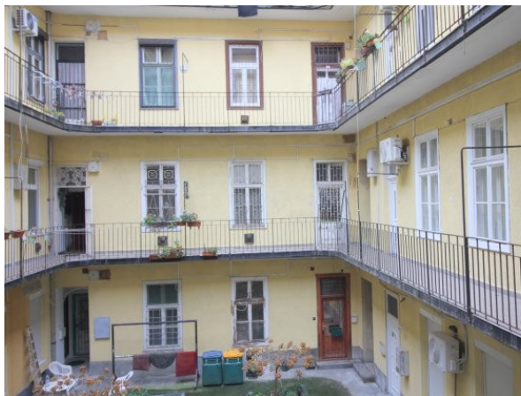
Társasház udvari homlokzata
