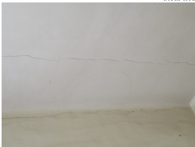
repedések a falon és a mennyezeten
