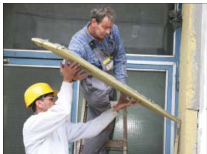
Szigetelik a panelházak homlokzatát a Baross utcában
