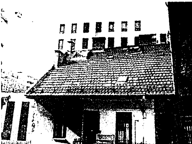
16. belső homlokzat, tető
